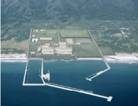
東通原子力発電所
